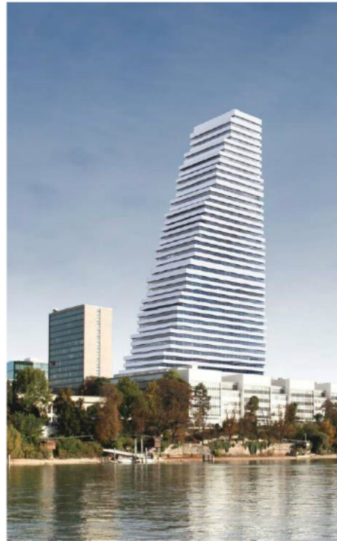
Schweiz, Basel Roche Tower 178 m
