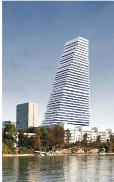
Schweiz, Basel Roche Tower 178 m
