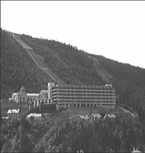
The Norsk Hydro Vemork plant
